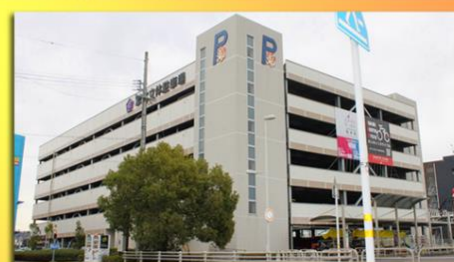
駐車場⑤ 多治見駅北立体駐車場 収容台数 417台
